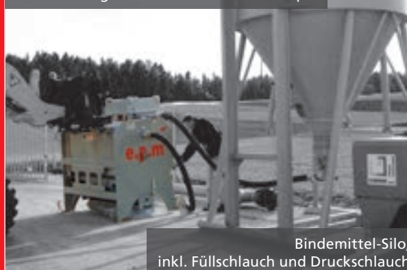
Befüllen mittels Druckluft
