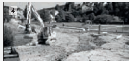
Die „reale“ Baustelle
