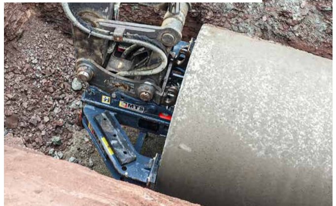
Hydraulischer Rohrschiebeadapter mit Seitenarm
