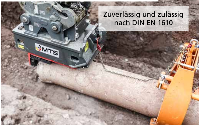
Hydraulischer Rohrschiebeadapter
