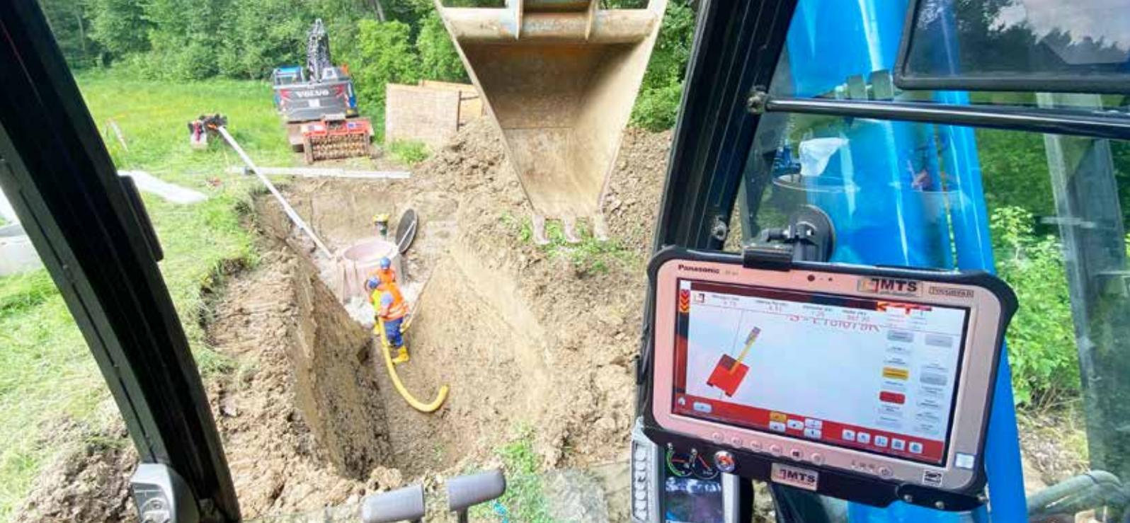
Nach einer 3D-Aufbereitung der Planungsvorgaben durch die Ingenieurin ist Baggerfahrer Erik Hofmann in der Lage, sämtliche Informationen zu Kanälen, Regenüberlaufbecken, Wasserleitungen und der Straße direkt in die MTS-Maschinensteuerung des Baggers zu übernehmen und danach exakt zu arbeiten.
