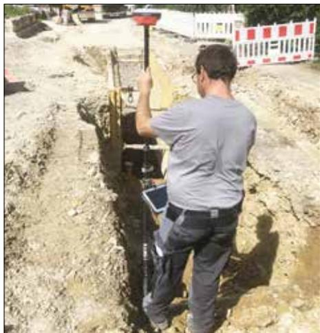
Mittels MTS-Rover nimmt der Polier die Qualitätsprüfung des Bauwerksmodells vor.
