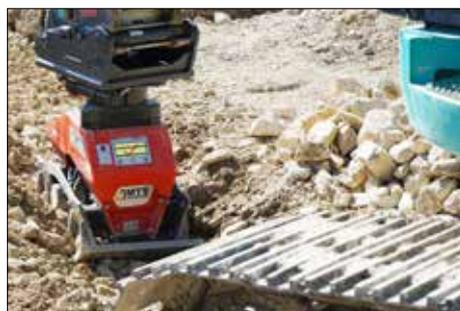
Die Qualität der Bodenverdichtung lässt sich mittels FDVK fortlaufend prüfen und dokumentieren.
