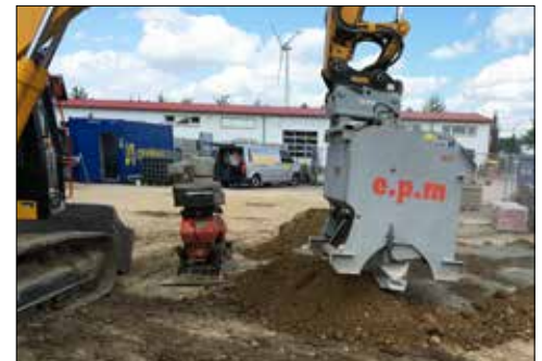
Der e.p.m-Bindemittelstreuer gibt den Tragschichtbinder HRB E4 dosiert auf den Boden.
