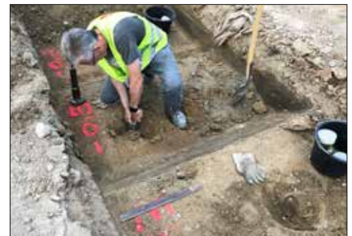
Eignungsprüfung im Probefeld, Felddichtebestimmung und Proctorversuch durch eigenen Baustoffprüfer.
