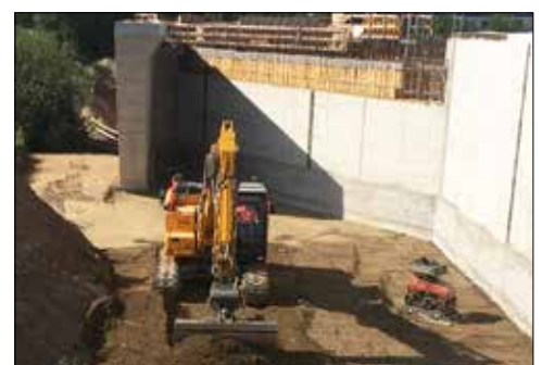
Der Kettenbagger mit OilQuick(OQ70/55) wechselt zwischen MTS-Anbauverdichter und Schwenklöffel.
