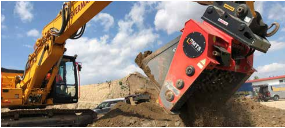
Qualifizierte Bodenverbesserung mit bindigem Boden zwecks Hinterfüllung eines Brückenwiderlagers.
