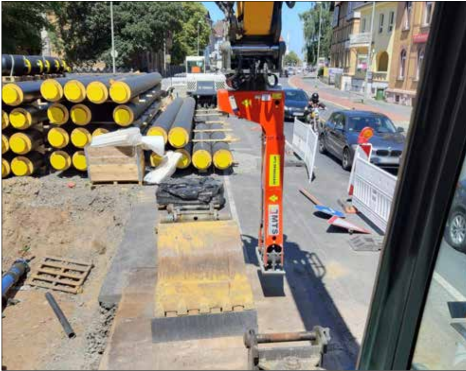
Um Mitarbeiter zu entlasten und auch unter erschwerten Rahmenbedingungen sicher, flexibel und effizient arbeiten zu können, automatisiert die Laudemann GmbH aus Sontra ihre Bauprozesse.
