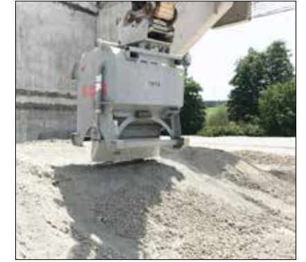
Qualifizierte Bodenverbesserung mittels e.p.m.-Bindemittelstreuer und MTS-Bodenrecycler erfüllt alle Anforderungen der strengen Eignungsprüfung mit Bravour.
