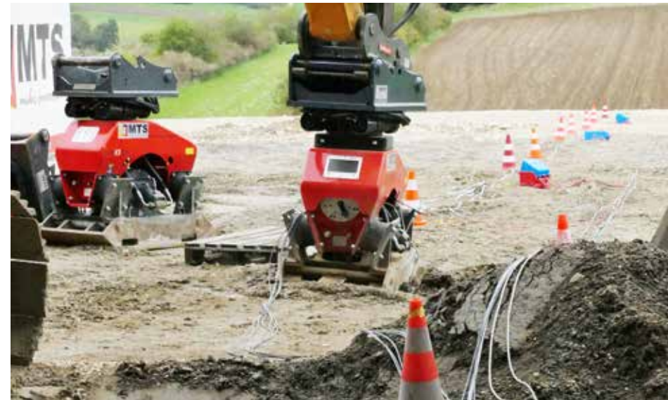
Messungen der Erschütterungsimission durch Anbauverdichter im Boden mittels Geophon-Messkette
