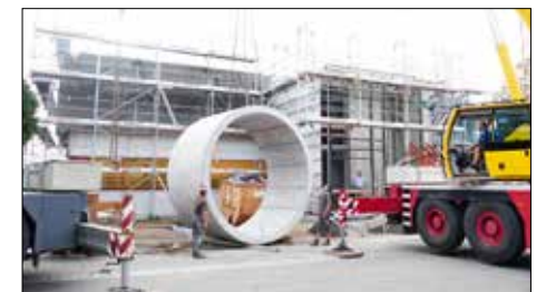
Das Kanalrohr im Eingangsbereich verweist auf die im Tiefbau verankerten Wurzeln von MTS.
