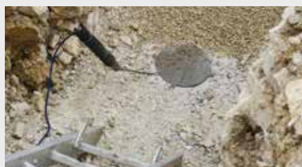
Messung der Spannungen in der Rohrbettung (Erddruckmessdose)
