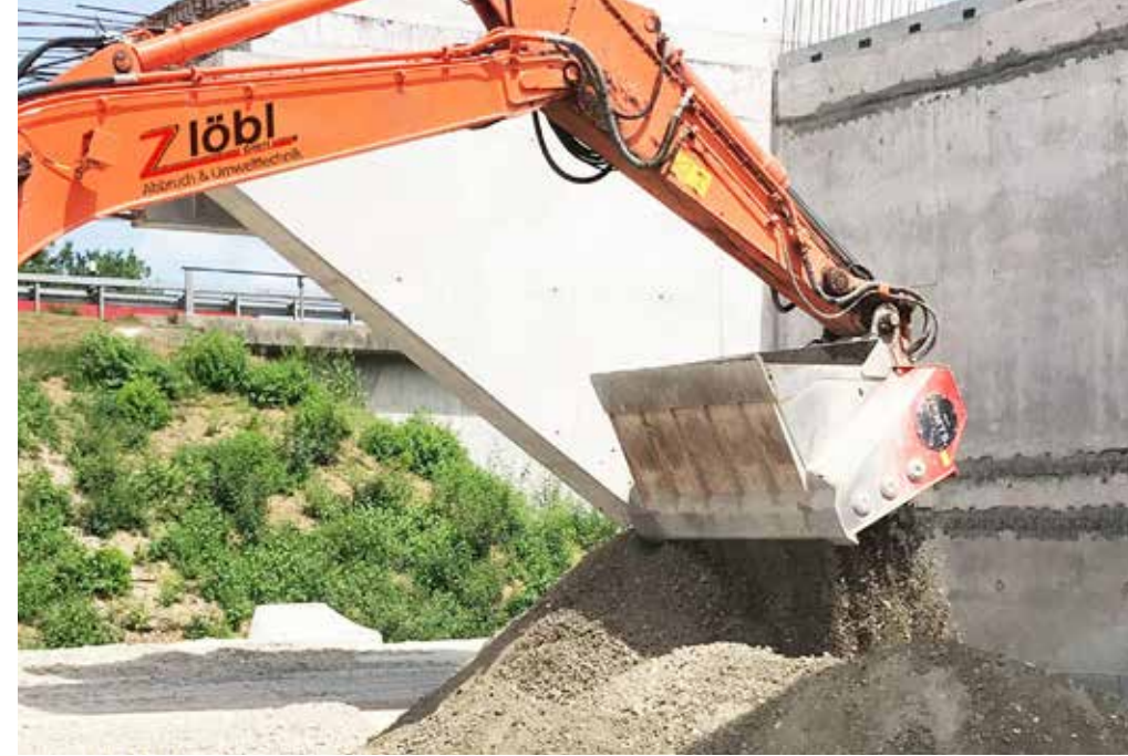
Qualifizierte Bodenverbesserung mittels e.p.m.-Bindemittelstreuer und MTS-Bodenrecycler erfüllt alle Anforderungen der strengen Eignungsprüfung mit Bravour.
