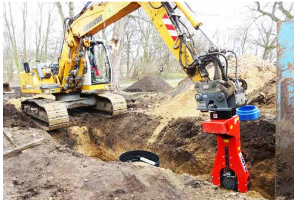
Wo besondere Herausforderungen an den Verdichter gestellt werden, ersetzt die Arbeit mit dem Universalverdichter das risikobehaftete Verdichten mit handgeführtem Stampfer.
