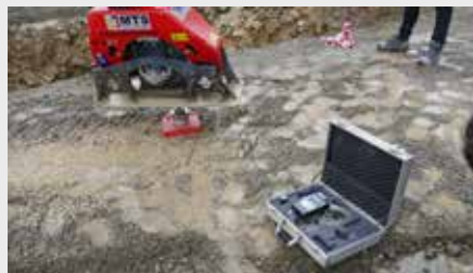
Messung der Auflast (Kraftmessdose direkt unter dem Anbauverdichter)
