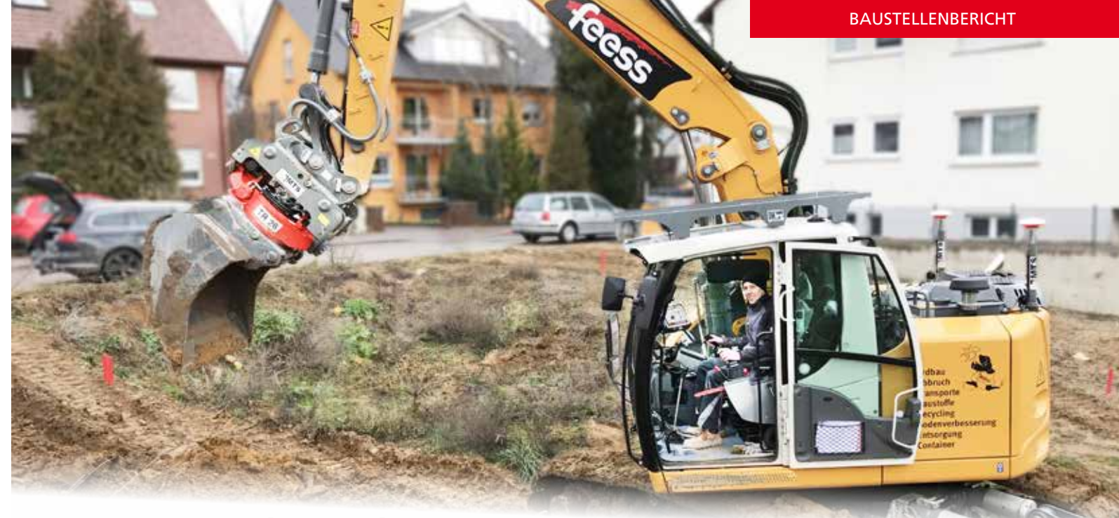
Die Kombi aus MTS-NAVI, MTS-Tiltrotator und OilQuick-Schnellwechsler bringt Benjamin Feeß rund 20 Prozent Zeitvorteil beim Aushub einer Baugrube auf einem alten Baufeld.
