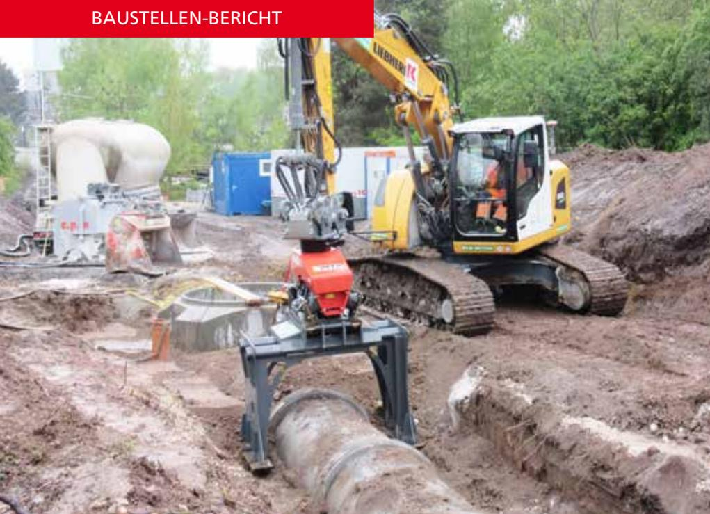
Eine saubere und spannungsfreie Verdichtung der Rohrleitungszone dank MTS-Doppelfuß-Verdichter
