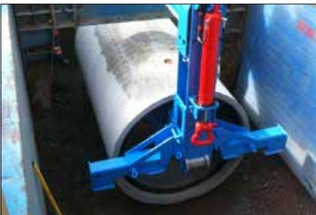
Um auch Großrohre schnell und sicher vom LKW abladen, zwischengelagern, wiederaufnehmen und einbauen zu können, entwickelte die MTS AG in enger Zusammenarbeit mit der Gollwitzer GmbH eine für den BAUMA-Innovationspreis nominierte und mit dem VBUM-Förderpreis ausgezeichnete Speziallösung: ein hydraulisches Rohrverlegerät, das Rohrleitungen von DN1200 - 2200 mit einer Gebrauchslast
