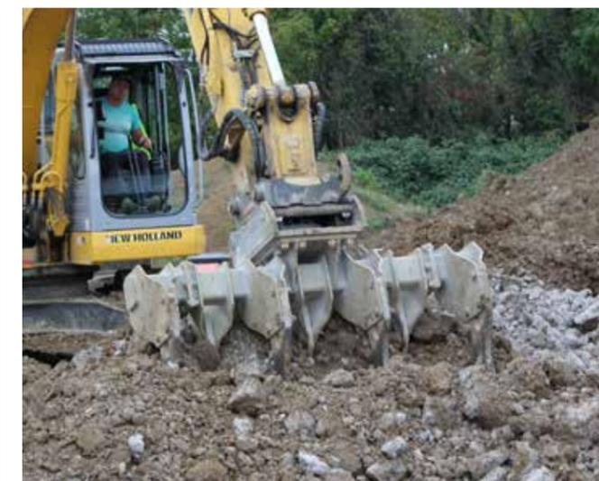
Zum Beispiel mit einem MTS-Kalkrechen und einem ALLU-Schaufel-separator.
