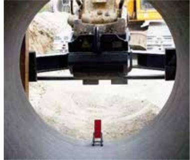
Getreu seinem Motto „aus der Praxis – für die Praxis“ hat MTS seinen hydraulischen Rohrschiebeadapter für die FBS-konforme Verlegung von Kanalrohrleitungen bis DN 1500 auferüstet. Die mittlerweile patentierte Detaillösung für das Update ist ein beidseitiger Seitenarm, der die hydraulisch regulierte Fügekraft an zwei seitlichen Punkten mittig auf das Rohr bringt.
