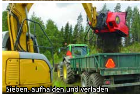
Bodenbehandlung mit Bindemittel/ Wiederverwertung von Abfallboden
