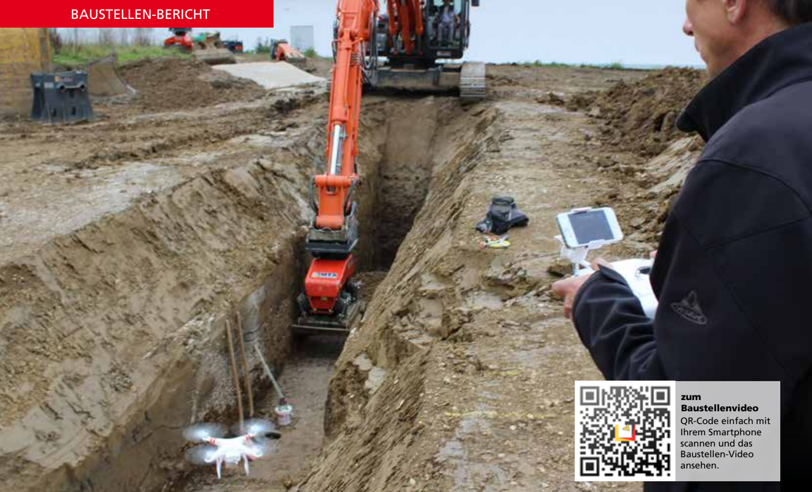
MTS-Geschäftsführer Rainer Schrode dokumentiert die moderne High-Tech-Baustelle mittels Drohne.
