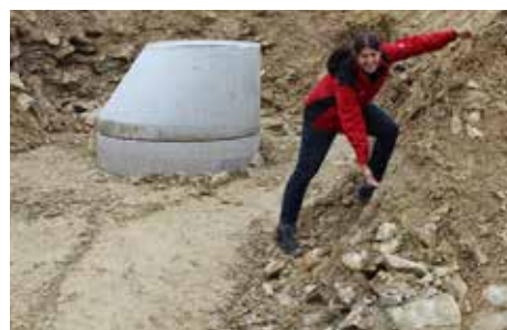
Lehmige Bereiche und aufgewittertes Material
