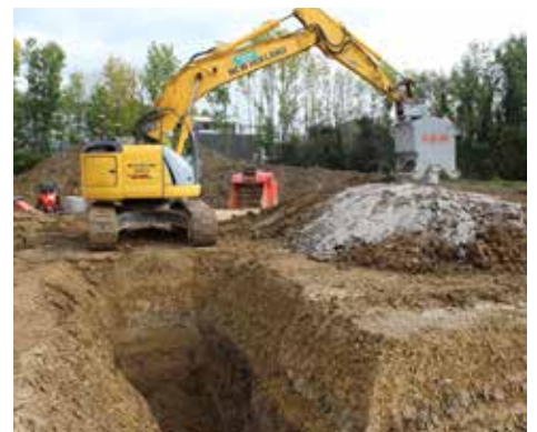
Das Bindemittel lässt sich mit dem e.p.m-Streuer dosiert auf den Aushub geben und mittels ALLU-Schaufelseparator sauber untermischen.
