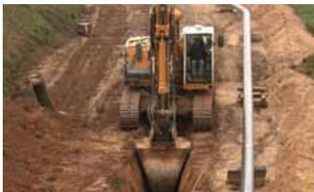
Aushub Pipelinegraben mit Trapezlöffel
