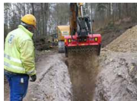
Bodenaufbereitung direkt vor Ort
