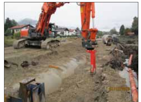
Der MTS-Universalverdichter im Einsatz.
