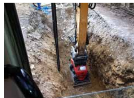
Automatisierte Verdichtung im Graben.
