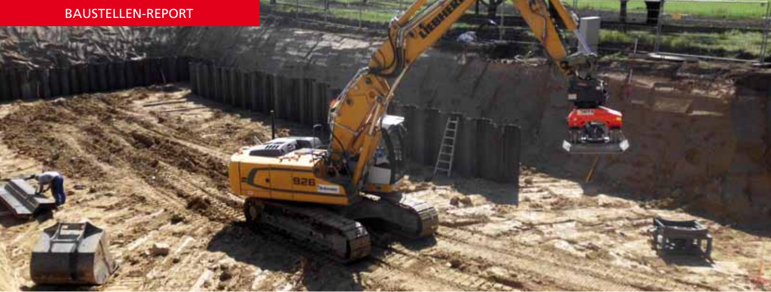
Dank Einsatz einer Spundwandklemme sparte Baufirma Anton Bokmeier rund 40 Prozent Abspundkosten.
