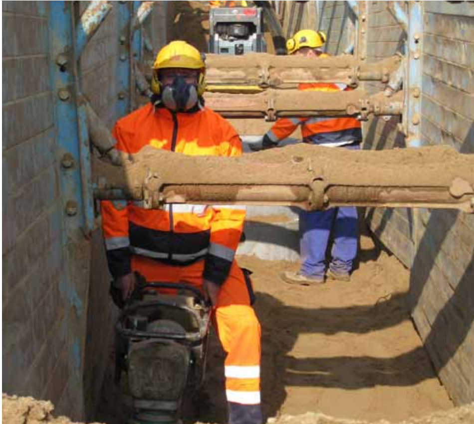
Handgeführte Geräte im Graben sind trotz geringer Emissionen gesundheitsgefährdend.
