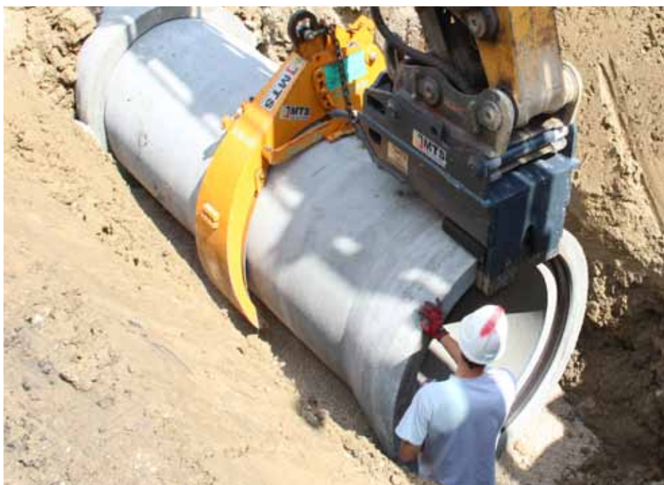
Die bis dato einzige Produktlösung auf dem Markt, um Rohre nach FSB-Richtlinie zu verlegen
