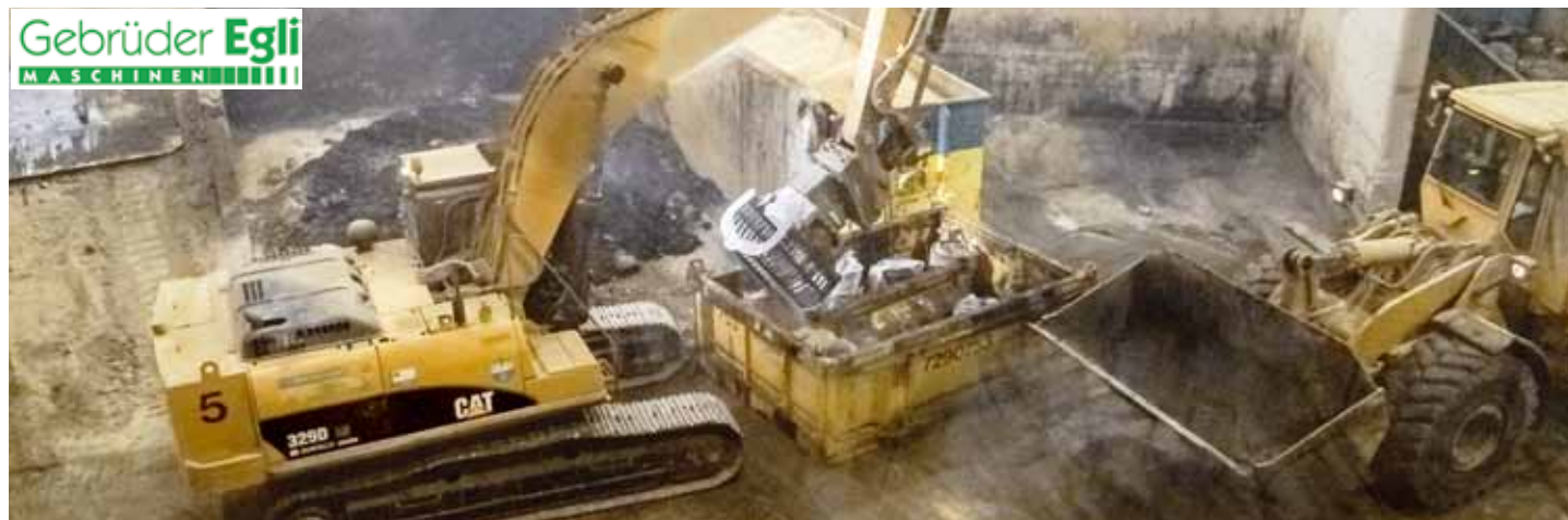
Fast gespenstisch: eine komplett automatisierte Baustelle fotografiert durch Sicherheitsglas. Hier der Egli-Greifer beim Rückbau von kontaminiertem Material.
