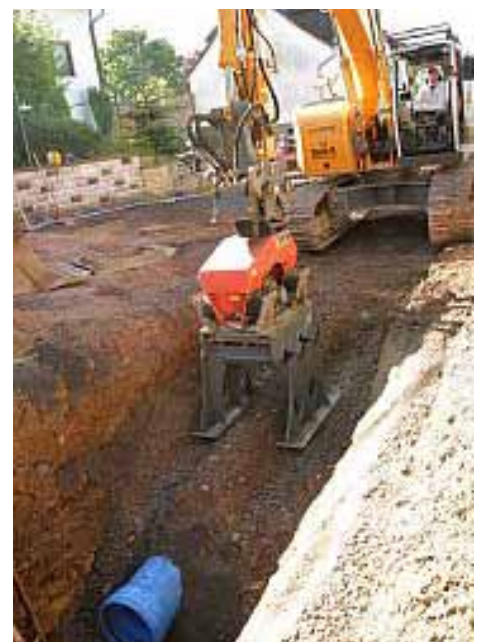
Spannungsfrei verdichten in der Rohrleitungszone
