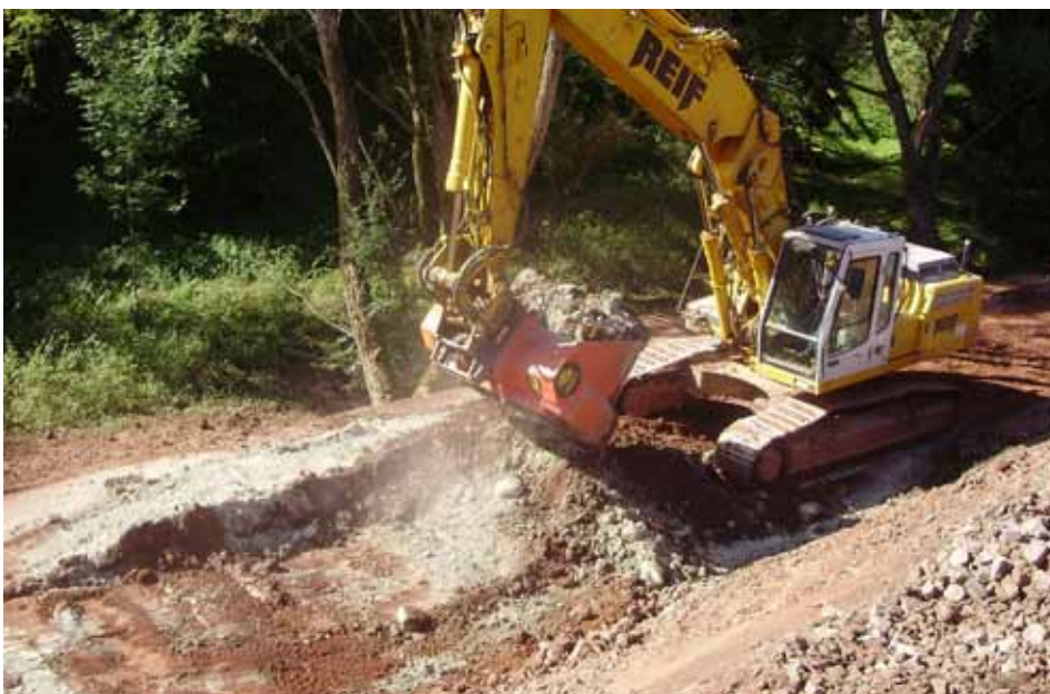
Der ALLU-Schaufelseparator sparte auf dieser Baustelle Transportkosten von rund 20.000 m 3 Boden
