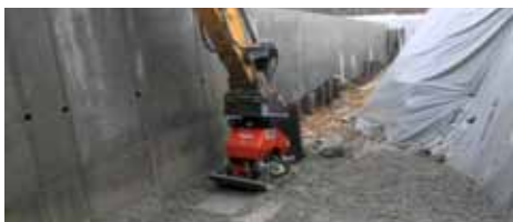
Auffüllen, Verdichten und Spunddielen ziehen
