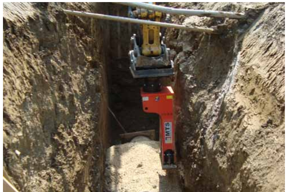
CO-Belastungen im Graben entfallen beim Einsatz von Anbauverdichtern komplett.
