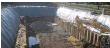
Wasserstand in der Baugrube
