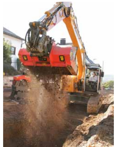
Beimischung von Stützkorn (DN 3-17)
