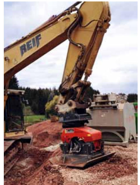
WA-Verdichter moduliert und verdichtet Böschungen bei doppelter Flächenleistung
