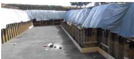
Abschalen der Bodenplatte
