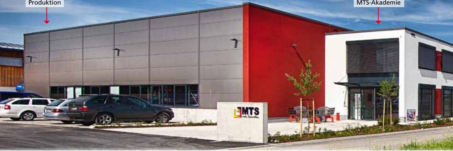
Der modern geschnittene Neubaukomplex auf dem MTS-Firmengelände wurde in einer Rekordbauzeit von 8 Monaten errichtet.
