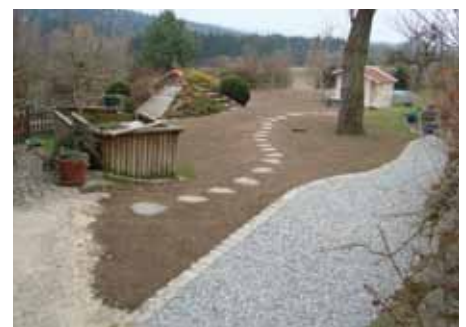
Die Baustelle nach gut 4 Wochen Bauzeit
