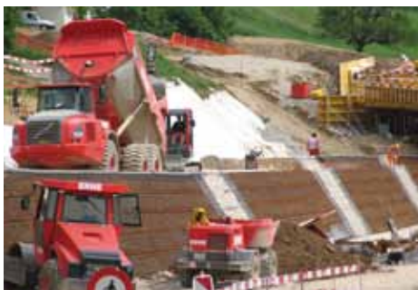
Wiedereinbau des verbesserten Bodens
