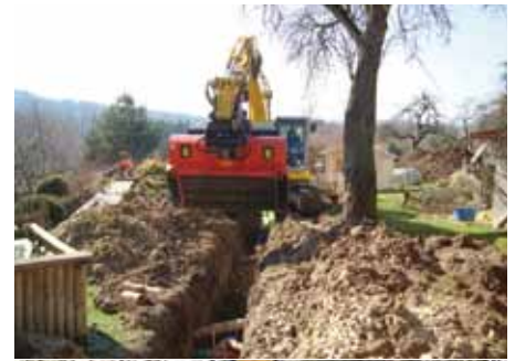
Gezielter Bodenabtrag mit OQ-Rotortilt
