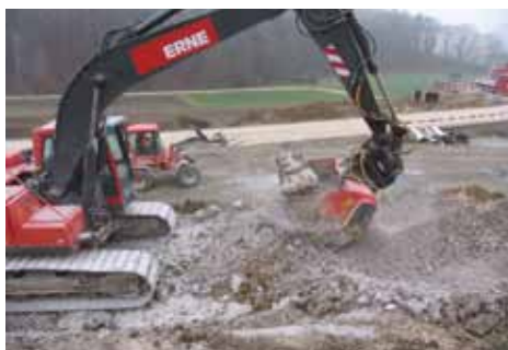
Bodenaufbereitung mit Dorosol C30
