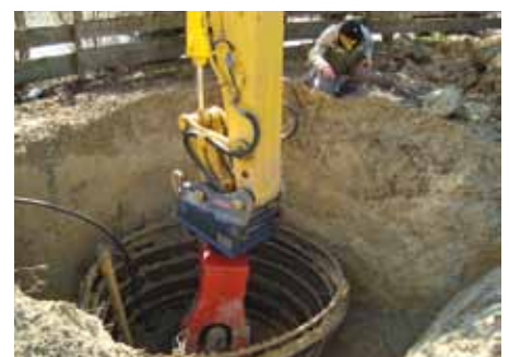
Verdichtung der Arbeitsräume mit einem MTS-Universalverdichter
