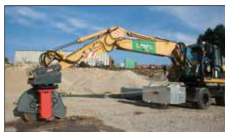
Prototyp im Praxistest der Schrode Bau GmbH
