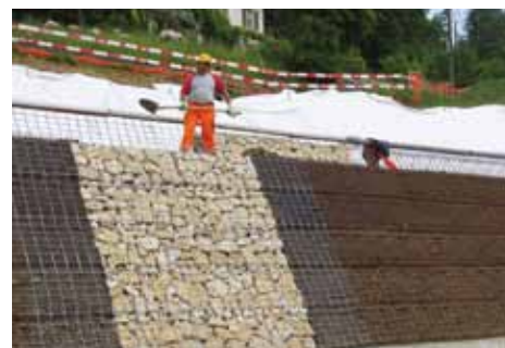
Teilfertige Hangsicherung
