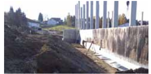
Bodenaufbereitung für Arbeitsräume
