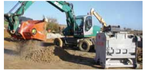
Bodenaufbereitung für Arbeitsräume
