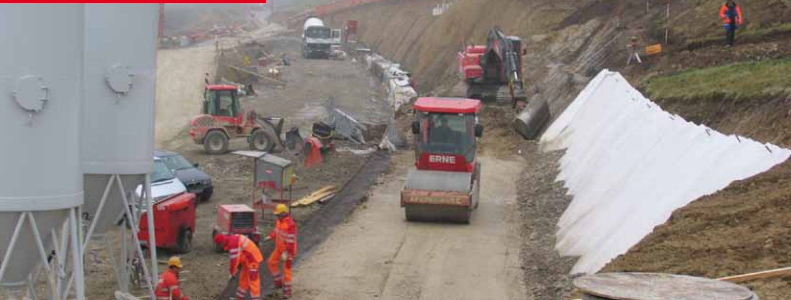
Bei dieser Hangsicherungsmaßnahme sparte Tiefbauer Erne 15.000 t Kiesmaterial durch Einsatz des e.p.m-Systems
