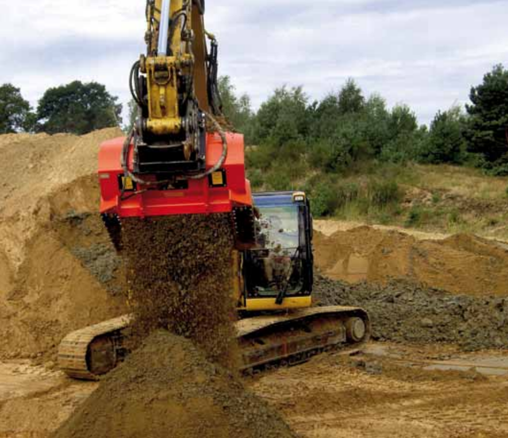
Bodenaufbereitung mit einem ALLU-Schaufelseparator
