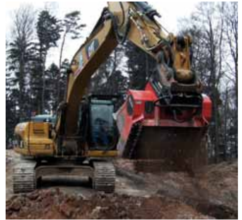
Bagger beim Siebvorgang
