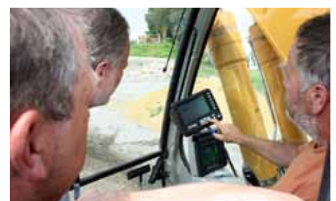
Praxisnahe Einweisungen auf dem Bagger
