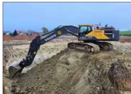
Mit der Unterstützung vom MTS- Navi wird die geforderte Böschungsneigung genau eingehalten.
