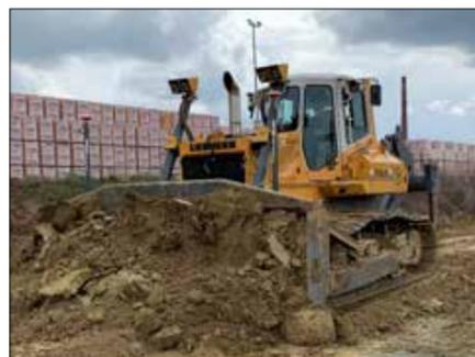
Mit dem MTS-Navi baut die Raupe das Material genau in den geforderten Schichtdicken ein.
