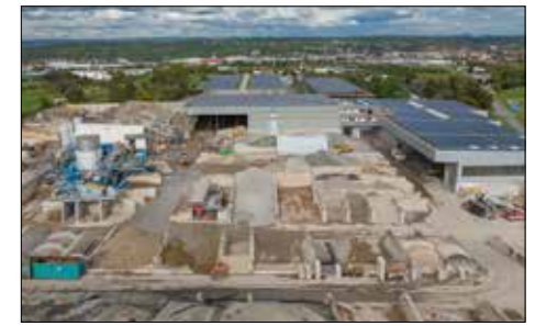
In den rund 60 Schüttgutboxen lassen sich bis zu 20.000 Tonnen Baustoffe zwischenslagern.
