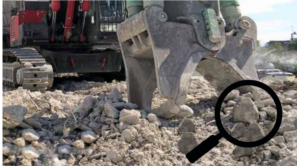
Egli Betonbeisser XMB 5.4 mit Bionic-Gebiss beim Abbruch
