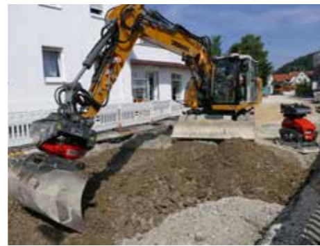
Effizientes Verfüllen mittels MTS-Tiltrotator.
