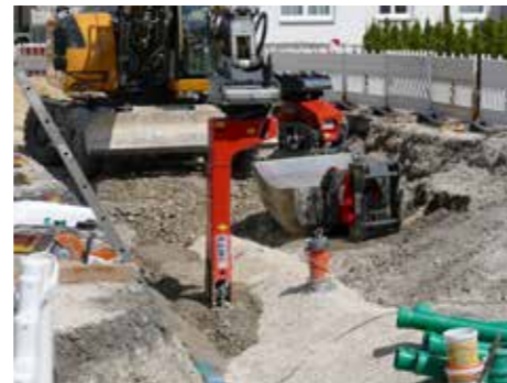
Sicheres Verdichten in der Rohrleitungszone mittels Universalverdichter.
