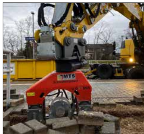
Verdichten einer Kabelquerung.
