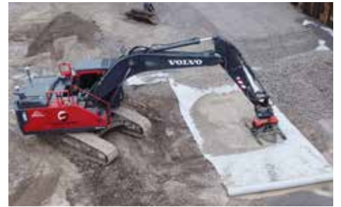
Der V8 WA verdichtet mit seiner 2 m breiten Wechselplatte die Schottertragschicht überm Vlies.
