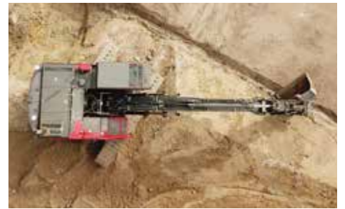
Mittels „Handgelenk am Baggerarm“ kann der Geräteführer Anbaugeräte in beliebige Positionen bringen.
